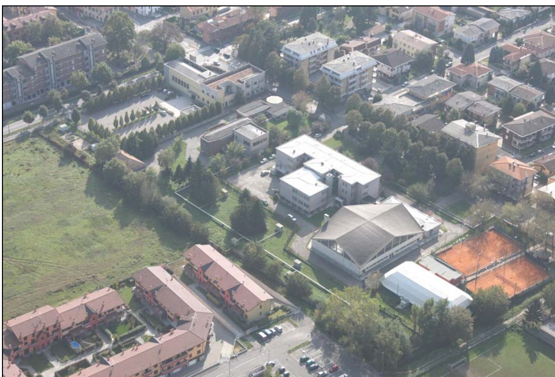
Viale Resistenza (Acquedotto comunale e campo pozzi)
