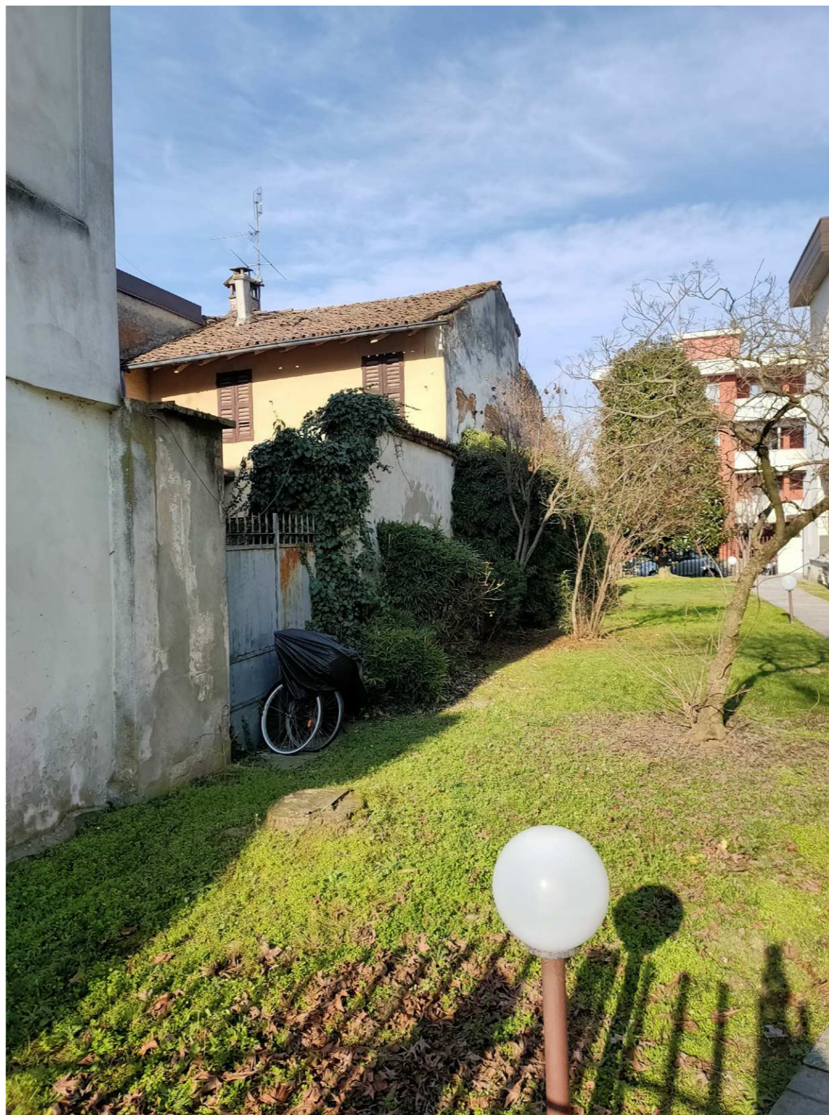
Vo4. Scorcio da Via Monte Pasubio attraverso il mappale 183 (è possibile osservare i fronti sud ed est dell'edificio oggetto di valutazione).
