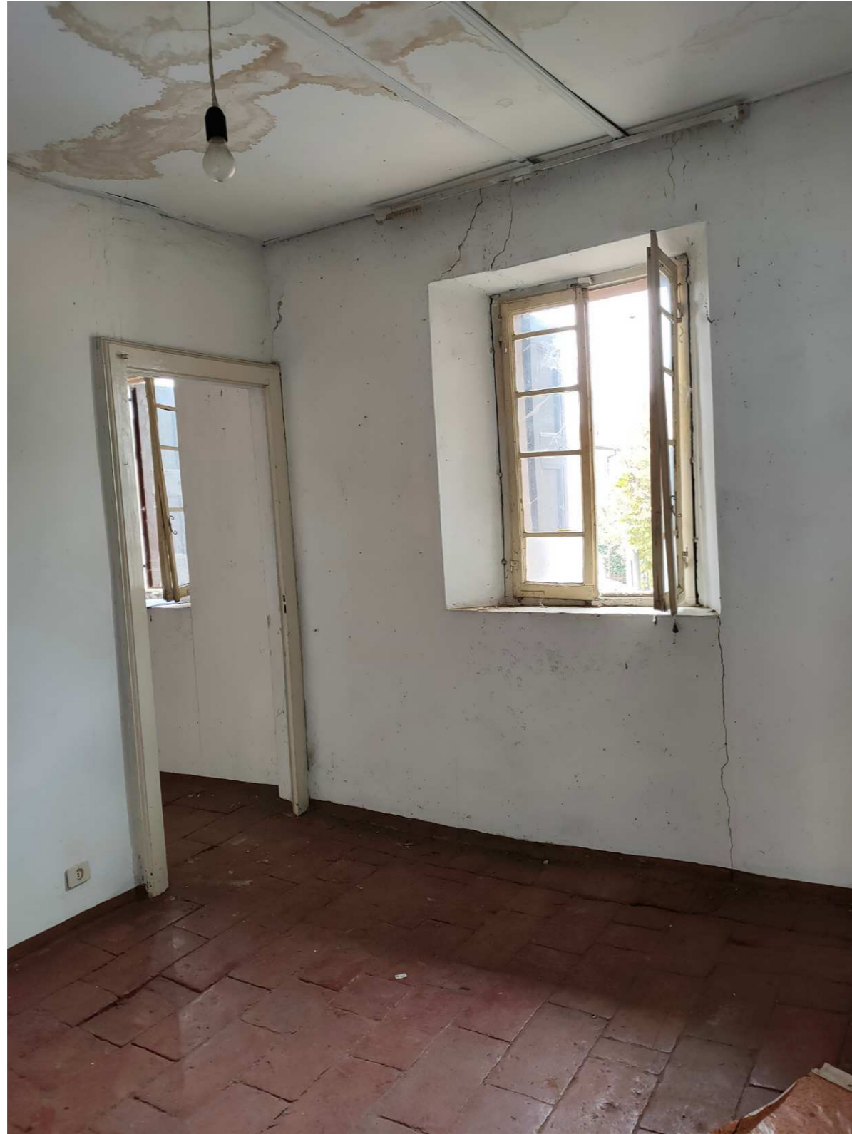
V26. Il ripostiglio
