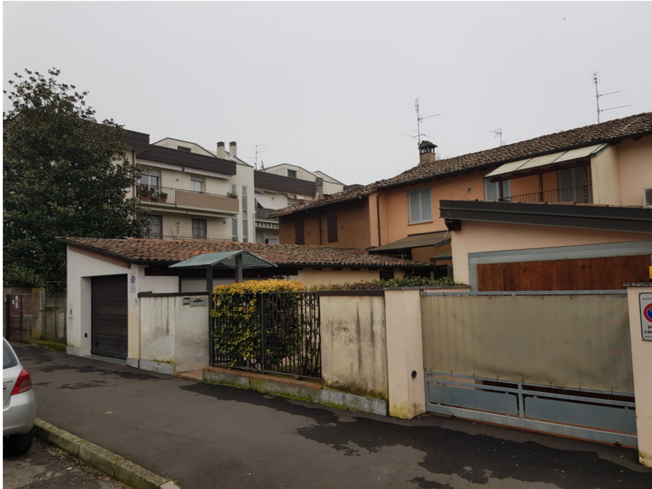
Vo3. Dettaglio della cortina edilizia lungo Vicolo Monte Doberdò (l'edificio oggetto di valutazione costituisce la "testata").
