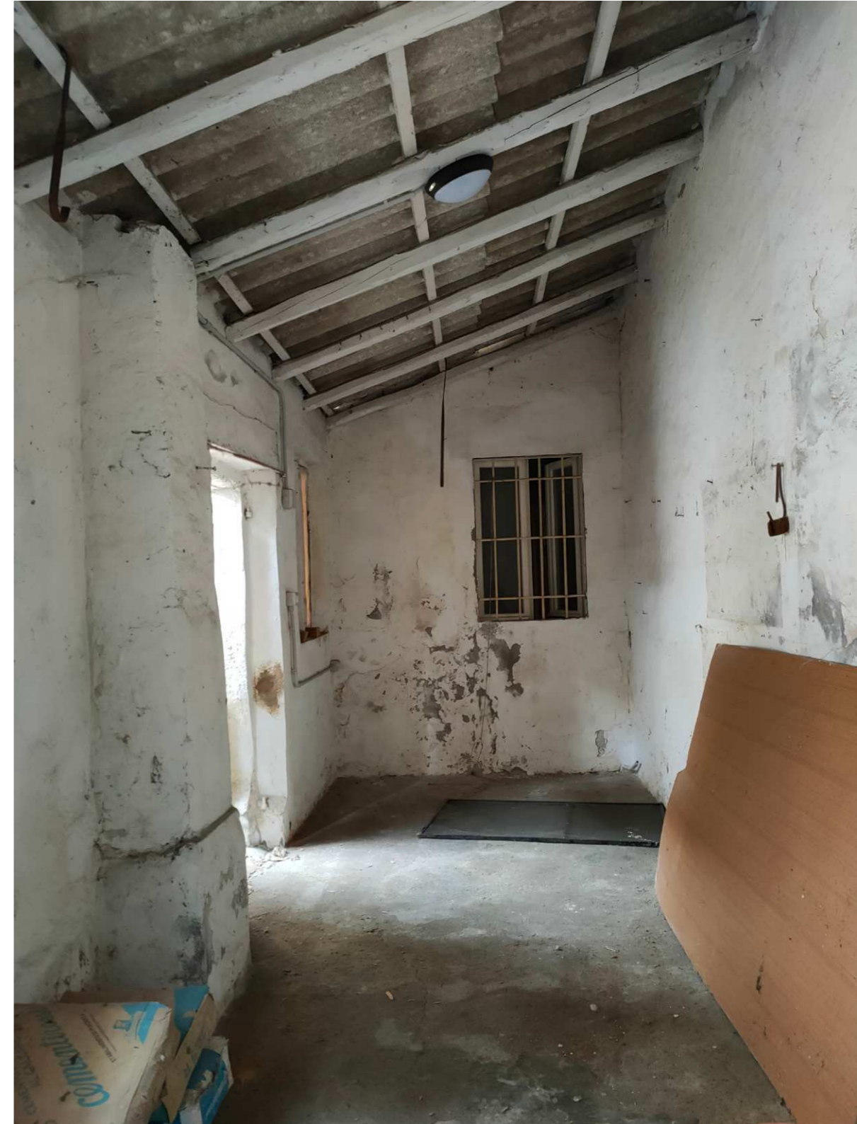
V15. Il rustico in direzione del corpo di fabbrica principale. La finestra sullo sfondo appartiene al bagno.
