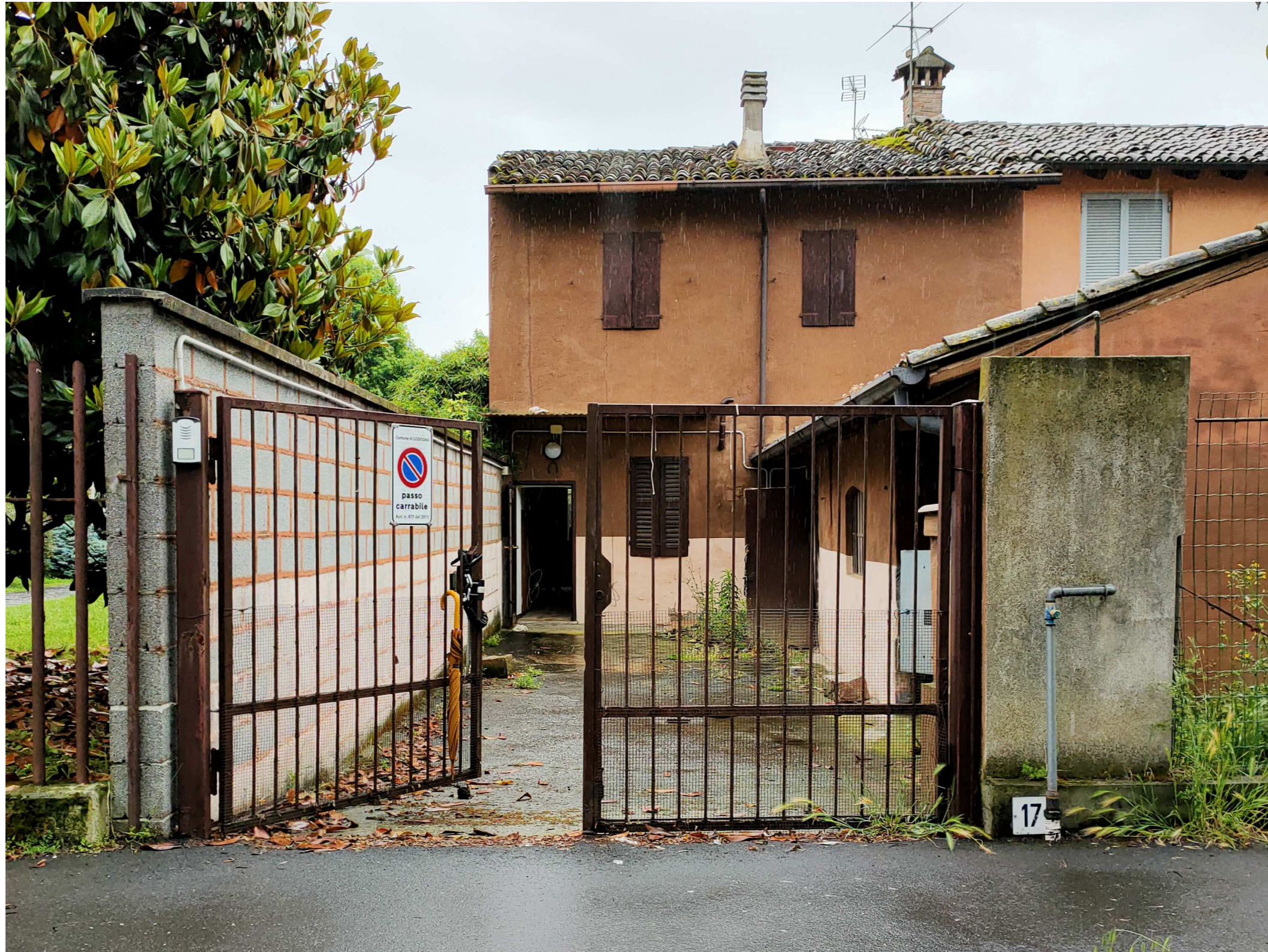
V05. Fronte nord lungo Vicolo Monte Doberdò. In primo piano il passo carraio e la recinzione; sullo sfondo l'edificio principale e il corpo secondario.
