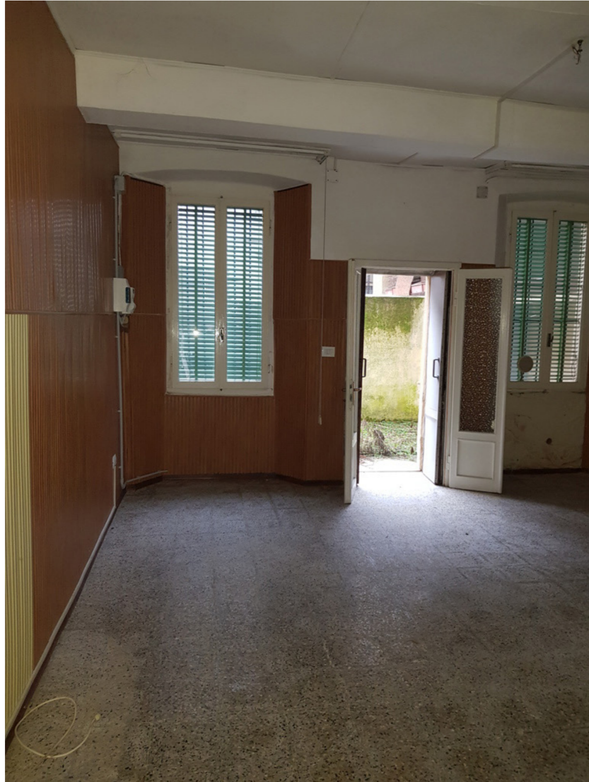
V10. Il soggiorno e le aperture verso il giardino sul fronte sud
