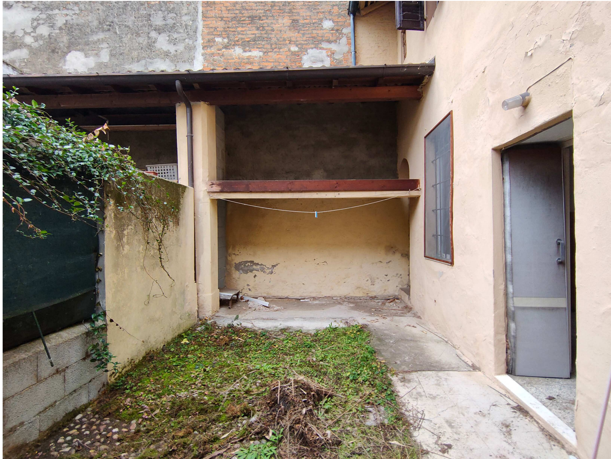
V16. Porticato con copertura lignea realizzato in aderenza al mappale 178. A sinistra la recinzione che separa la proprietà dal mappale 181 sub.701; a destra il corpo di fabbrica principale.
