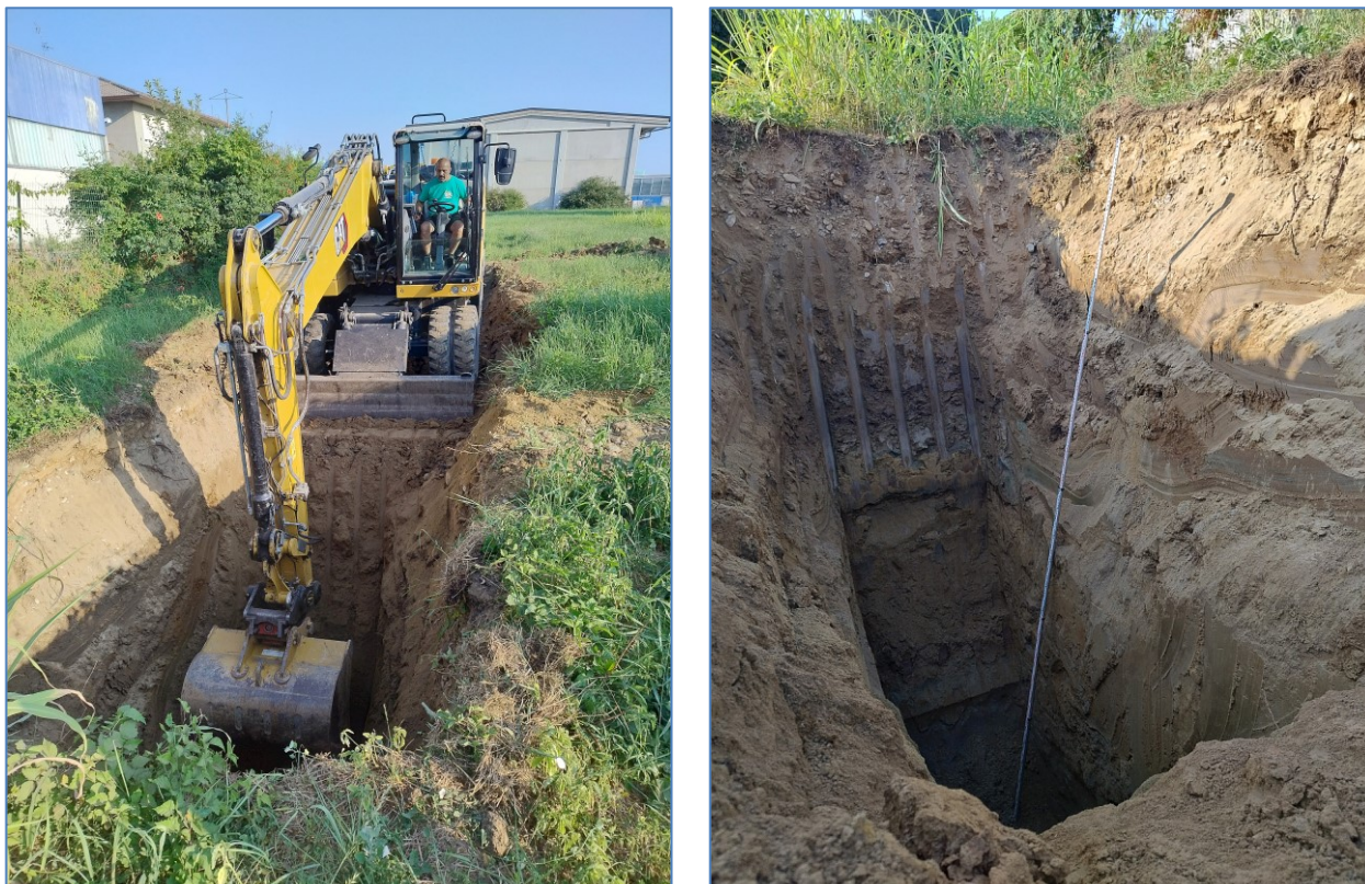
Fig. 6. Allestimento della trincea (sinistra) e verifica della locale stratigrafia (destra).
